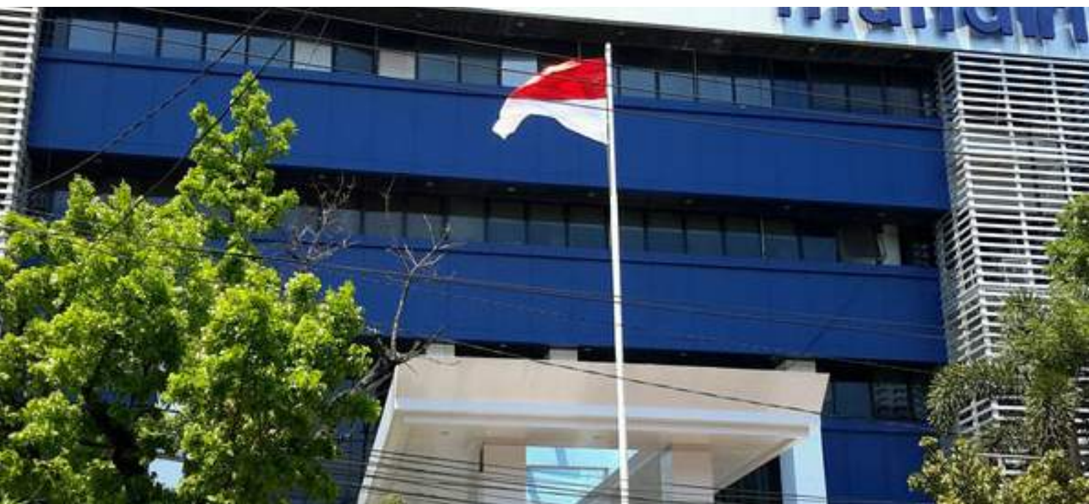
Mandiri Kantor Wilayah Makassar Proyek : service and maintenance
